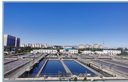
再生水厂好氧颗粒污泥项目
