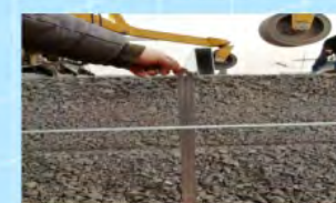
■ 水泥稳定碎石基层 Cement stabilized gravel base
